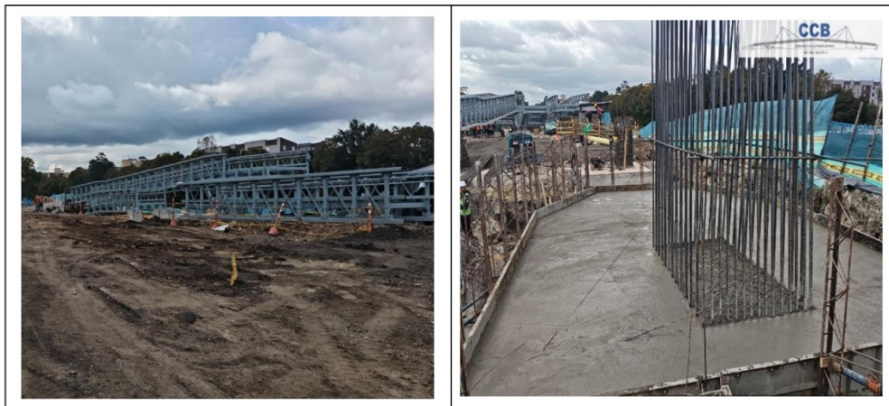
Fotografía N°1: Actividades de obra de cimentación y montaje.
