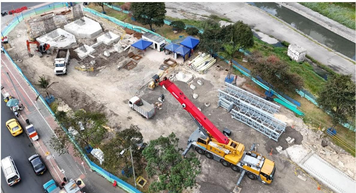
Fotografía N°5: Estructura Metálica en preensamble, en costado oriental
