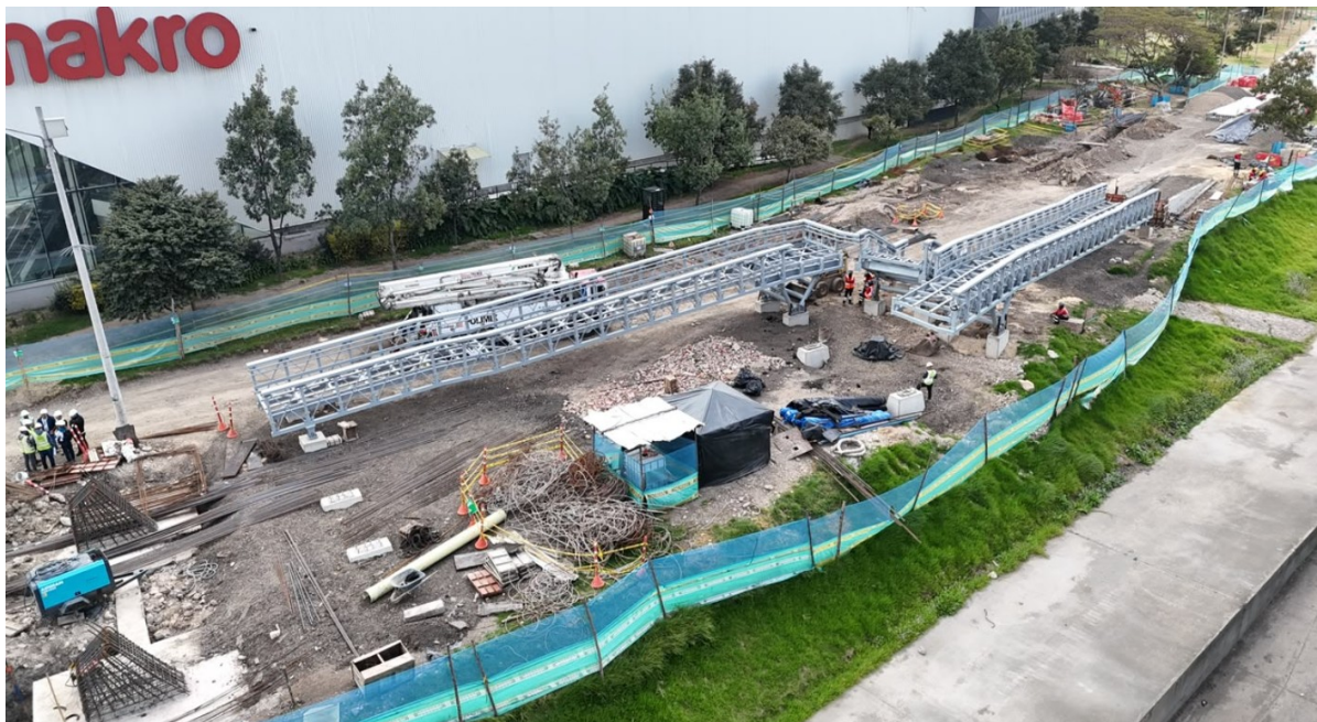
Fotografía N°4: Estructura Metálica izada, en costado occidental
