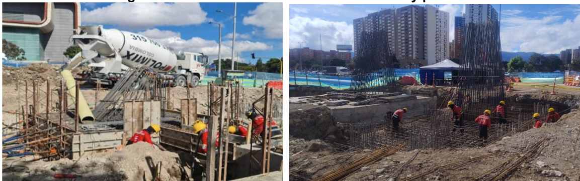
Fotografía N°2: Actividades de fundida de dados y pedestales.
