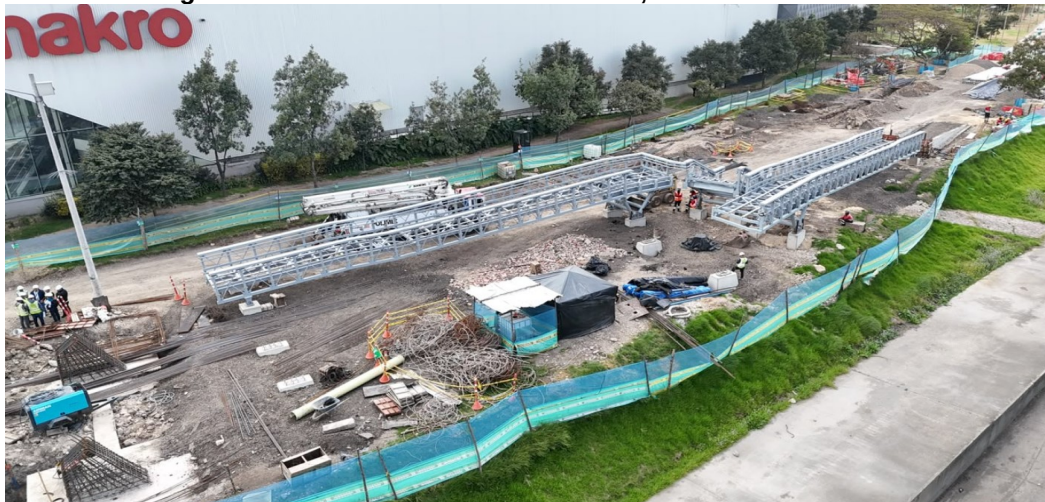
Fotografía N°4: Estructura Metálica izada, en costado occidental
