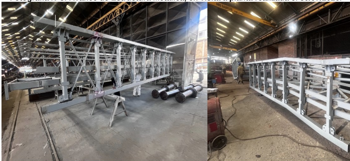
Fotografía N°3: Avance de Estructura Metálica, en visita a planta realizada el 30/07/2026.
