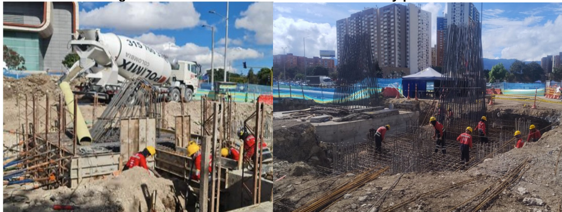
Fotografía N°2: Actividades de fundida de dados y pedestales.
