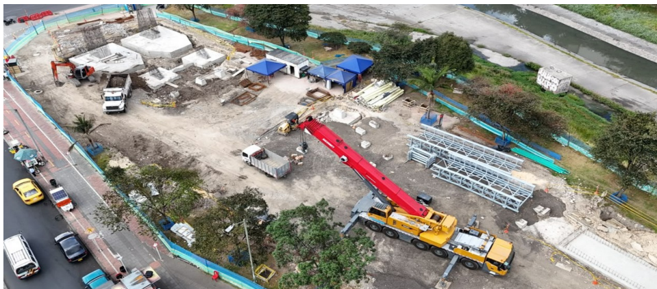
Fotografía N°5: Estructura Metálica en preensamble, en costado oriental
