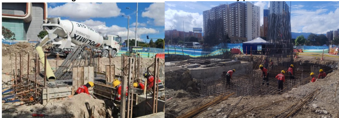
Fotografía N°2: Actividades de fundida de dados y pedestales.
