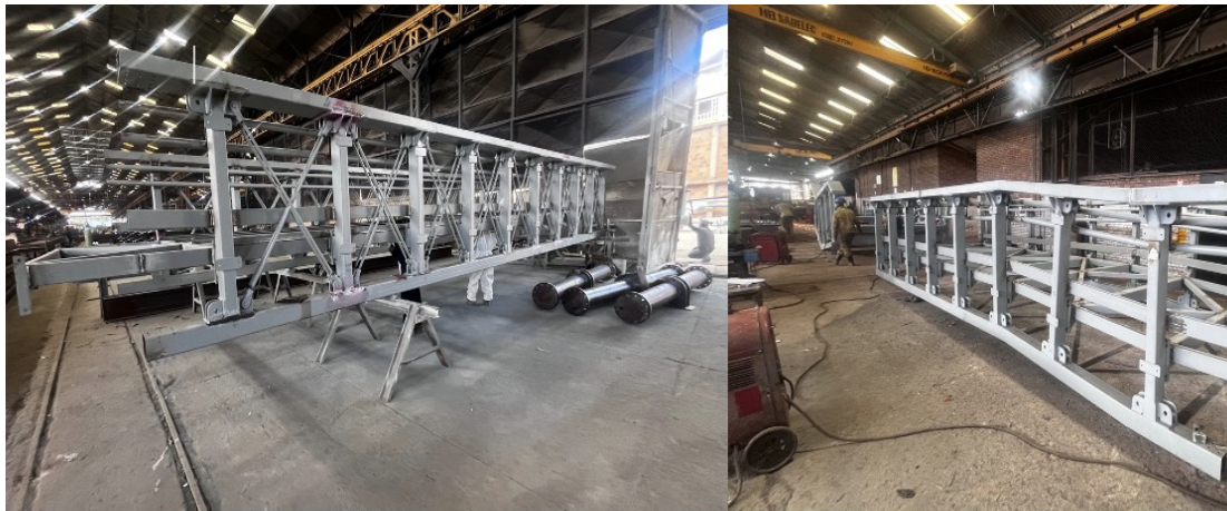
Fotografía N°3: Avance de Estructura Metálica, en visita a planta realizada el 30/07/2026.
