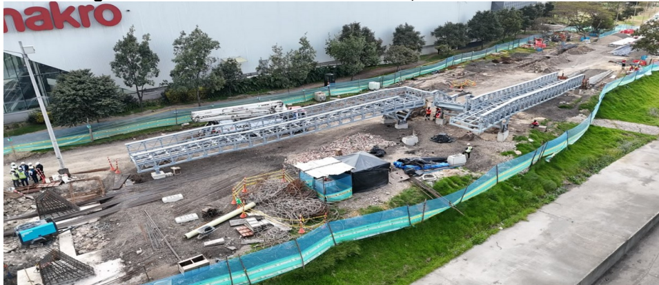
Fotografía N°4: Estructura Metálica izada, en costado occidental
