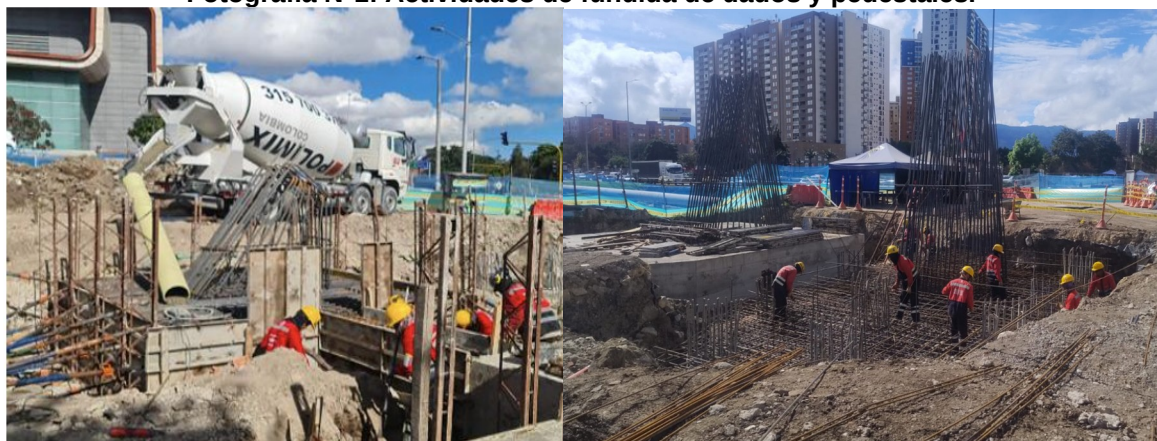
Fotografía N°1: Actividades de fundida de dados y pedestales.
