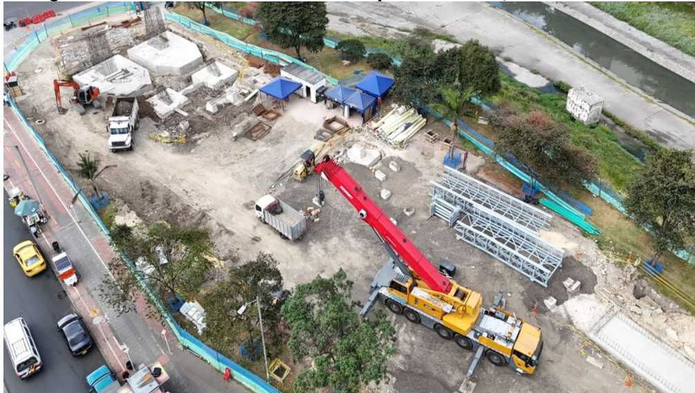
Fotografía N°4: Estructura Metálica en preensamble, en costado oriental
