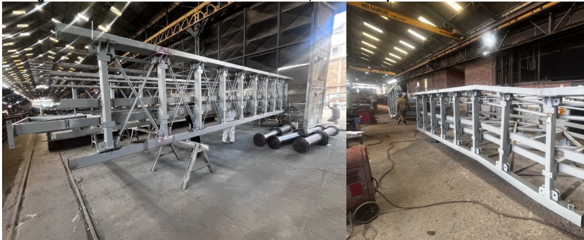
Fotografía N°2: Avance de Estructura Metálica, en visita a planta realizada el 30/07/2026.
