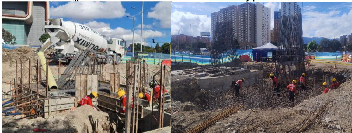
Fotografía N°1: Actividades de fundida de dados y pedestales.
