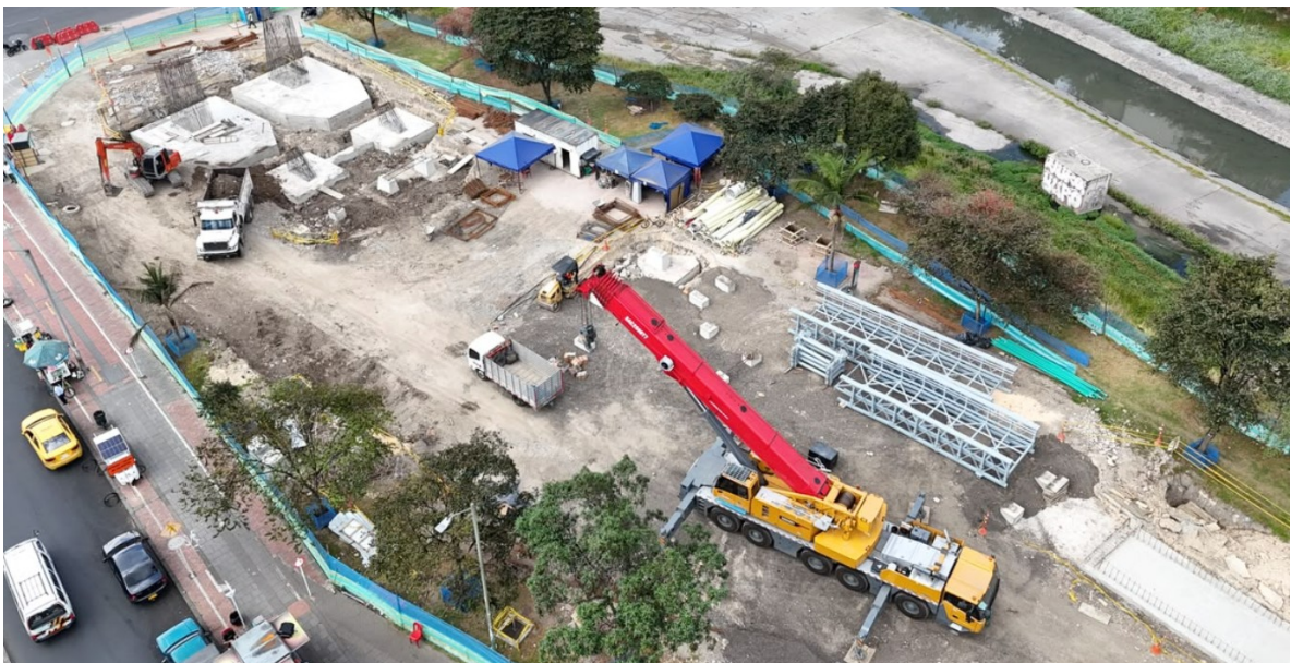
Fotografía N°4: Estructura Metálica en preensamble, en costado oriental
