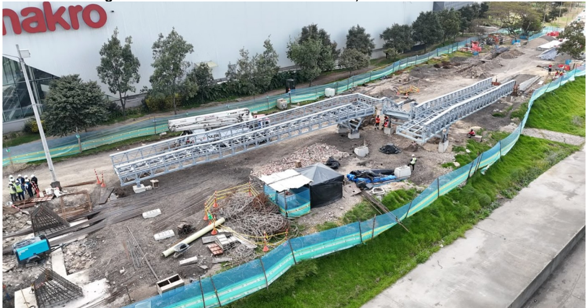
Fotografía N°3: Estructura Metálica izada, en costado occidental
