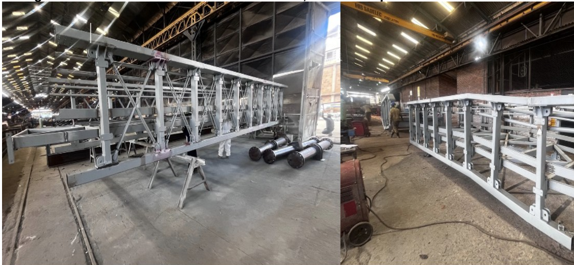
Fotografía N°2: Avance de Estructura Metálica, en visita a planta realizada el 30/07/2026.
