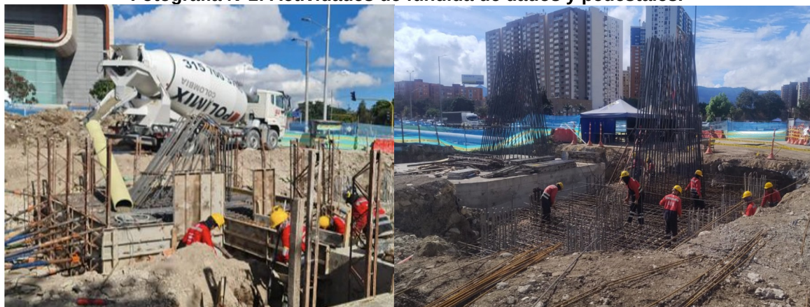
Fotografía N°1: Actividades de fundida de dados y pedestales.
