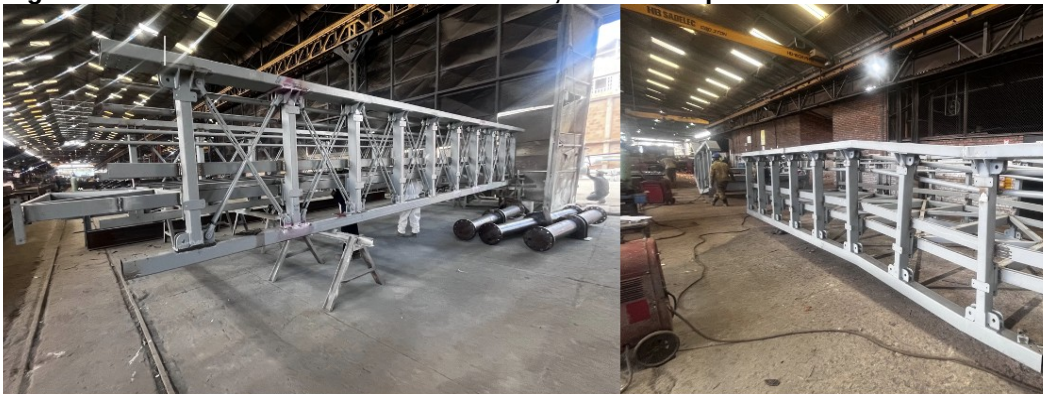
Fotografía N°2: Avance de Estructura Metálica, en visita a planta realizada el 30/07/2026.
