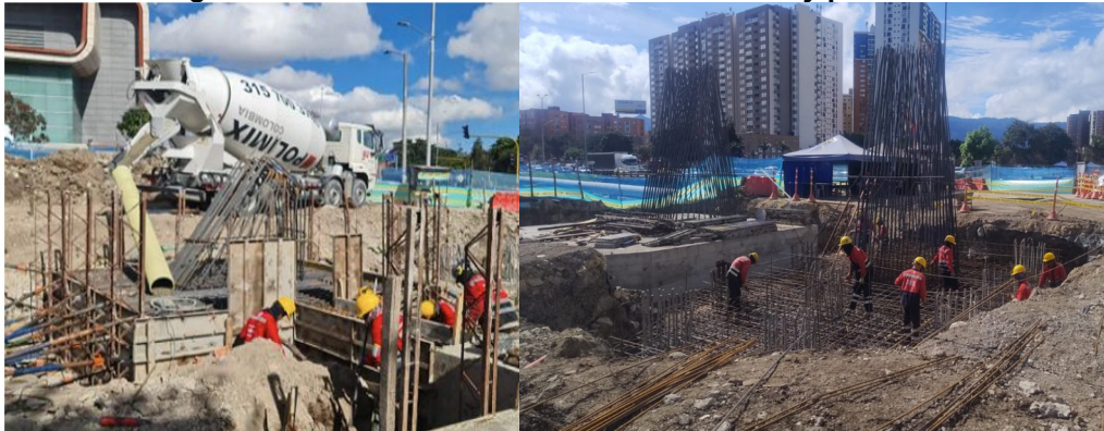
Fotografía N°1: Actividades de fundida de dados y pedestales.
