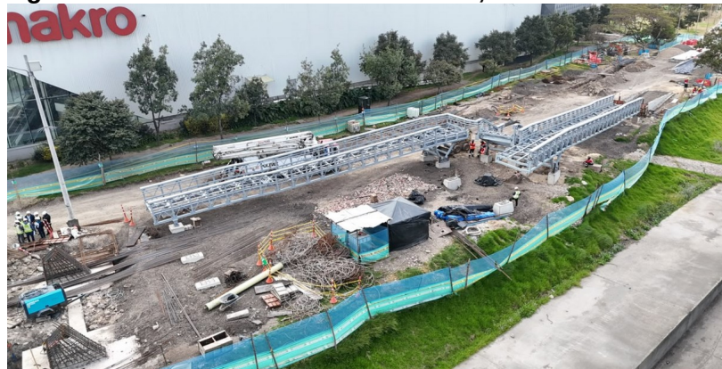
Fotografía N°3: Estructura Metálica izada, en costado occidental
