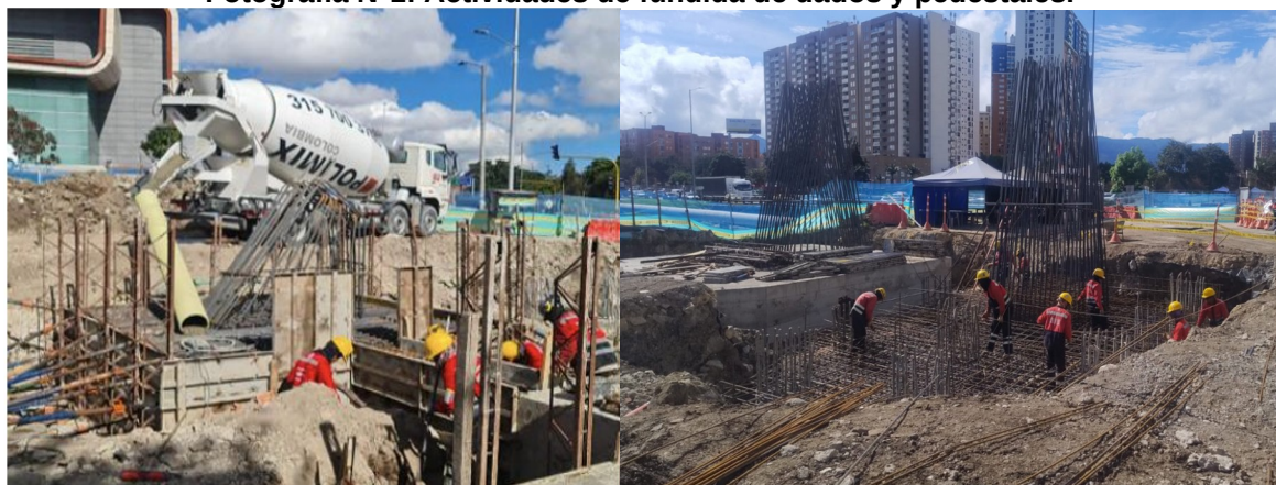
Fotografía N°1: Actividades de fundida de dados y pedestales.
