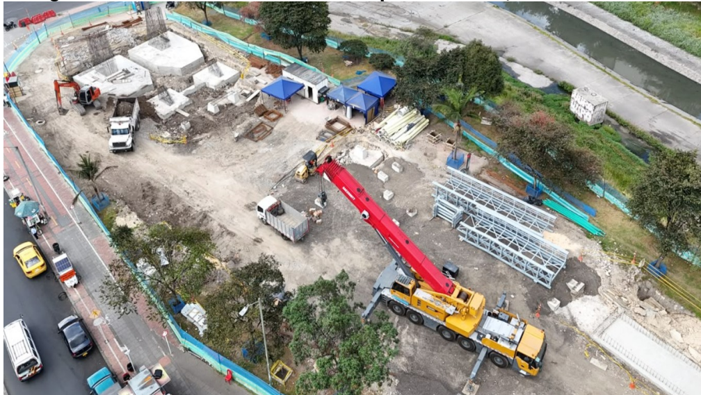
Fotografía N°4: Estructura Metálica en preensamble, en costado oriental
