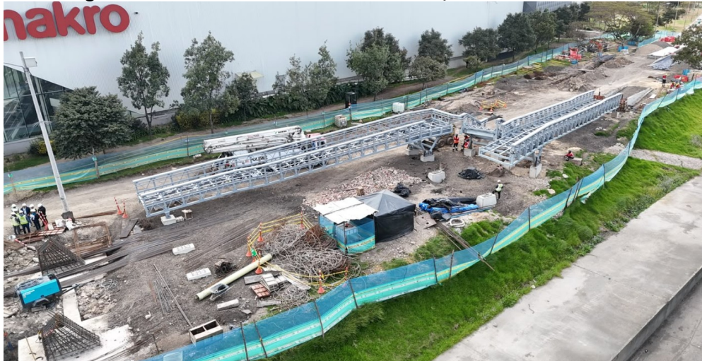
Fotografía N°3: Estructura Metálica izada, en costado occidental
