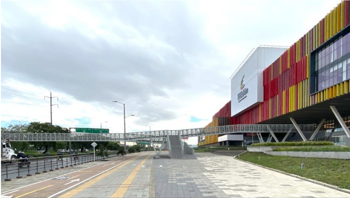
Imagen 1 – Panorámica del Puente. Fuente Construcciones Planificadas
