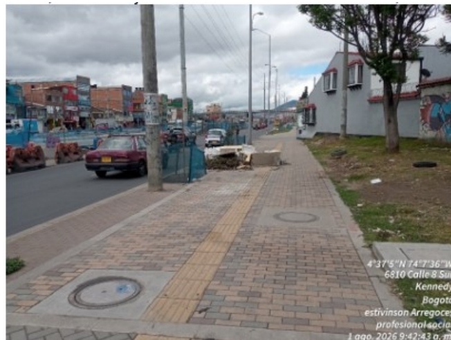
Presencia de residuos sólidos en la esquina de la calle 8sur. Fuente: Elaboración propia
