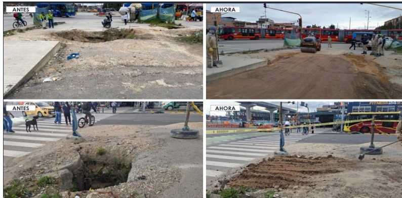
7. Colocación de asfalto
