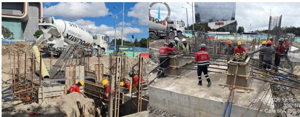
Fotografía N°2: Actividades de fundida de dados y pedestales.
