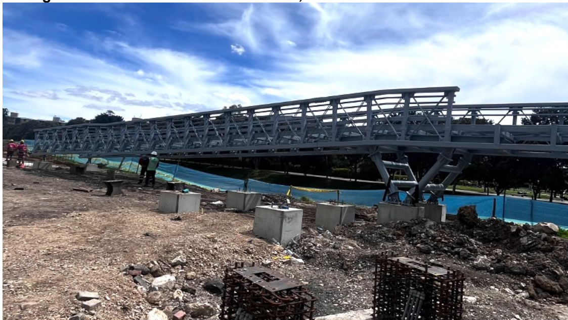
Fotografía N°4: Estructura Metálica izada, en costado occidental el 21/07/2026.
