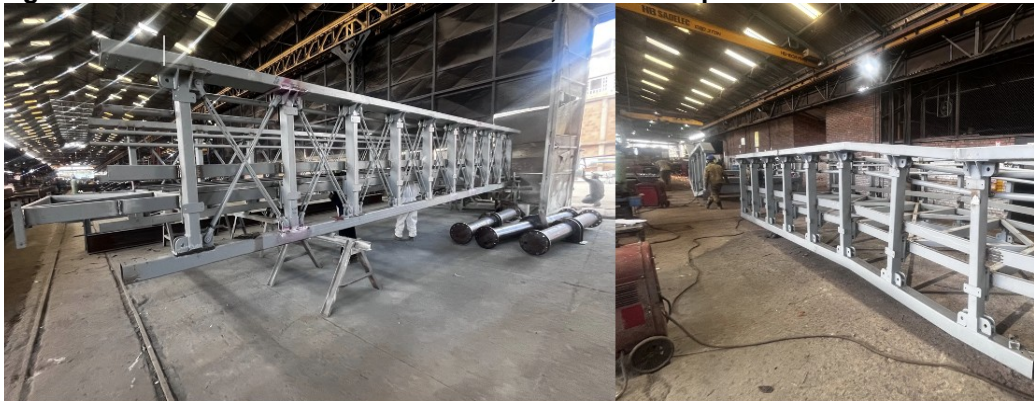
Fotografía N°3: Avance de Estructura Metálica, en visita a planta realizada el 30/07/2026.
