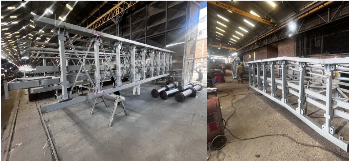
Fotografía N°3: Avance de Estructura Metálica, en visita a planta realizada el 30/07/2026.
