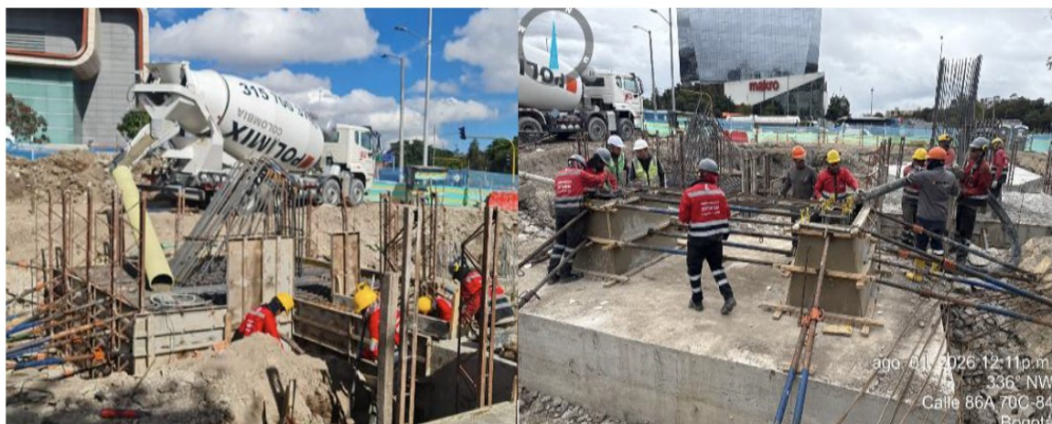
Fotografía N°2: Actividades de fundida de dados y pedestales.
