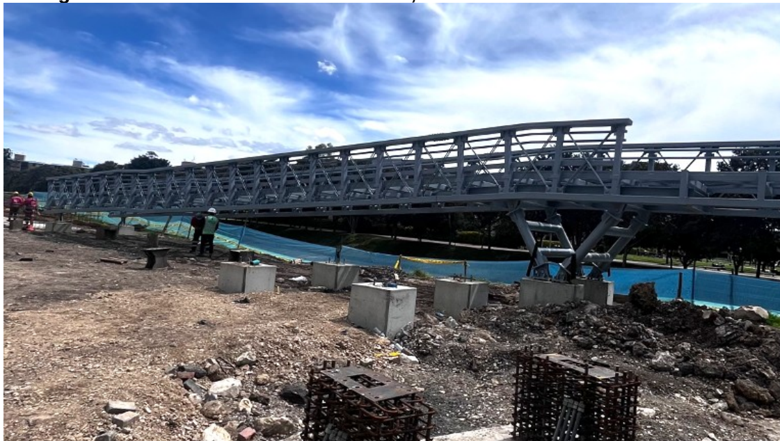
Fotografía N°4: Estructura Metálica izada, en costado occidental el 21/07/2026.
