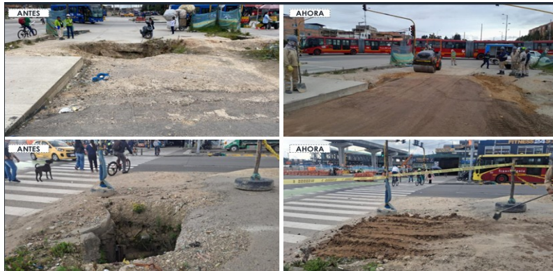
7. Colocación de asfalto
