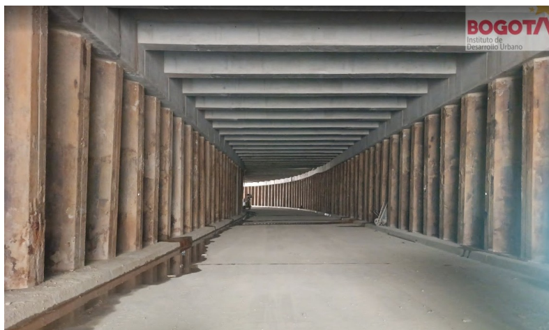
Imagen al interior del deprimido
