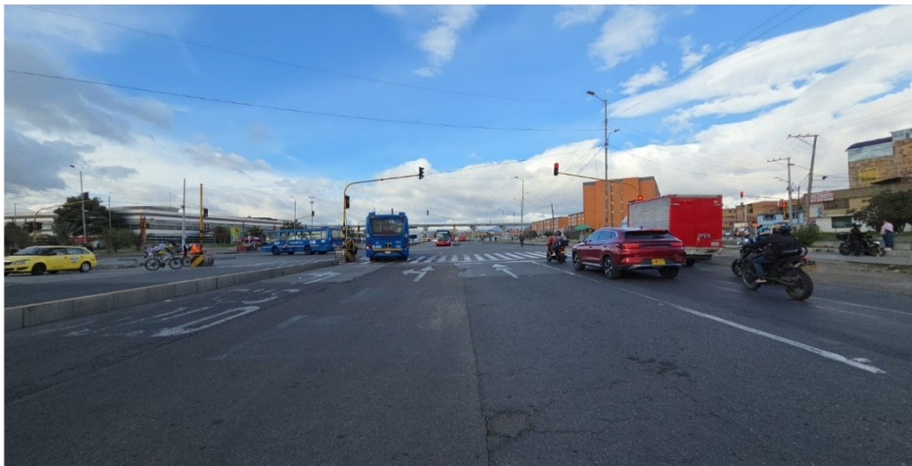
Ciudad de Cali con Calle 46 sur - sentido Sur Norte
