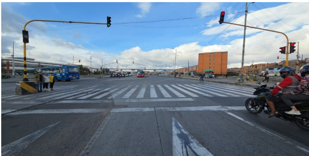
Av. Ciudad de Cali con Calle 46 sur - sentido Sur Norte
