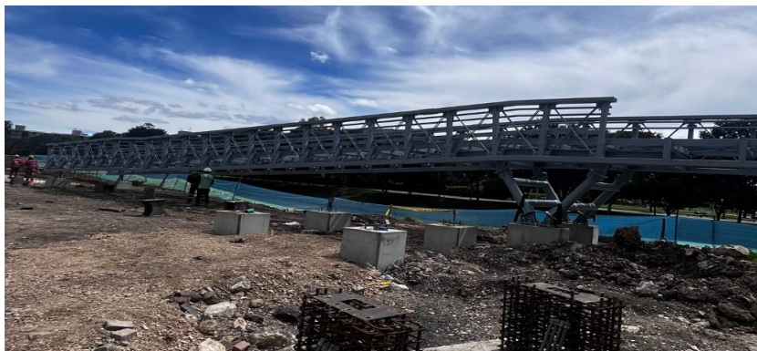
Fotografía N°4: Estructura Metálica izada, en costado occidental el 21/07/2026.
