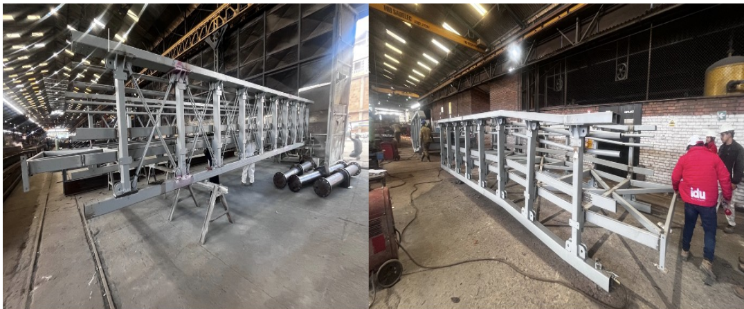
Fotografía N°2: Avance de Estructura Metálica, en visita a planta de producción
