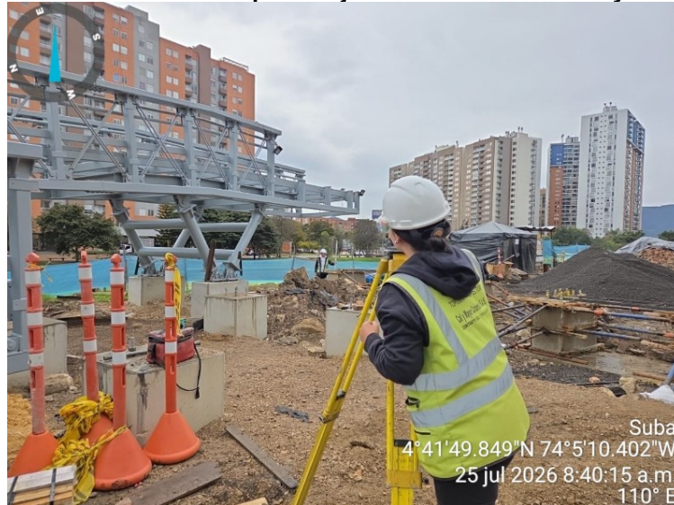
Fotografía N°5: Control de niveles para izaje de tramo de escalera y rampa occidental
