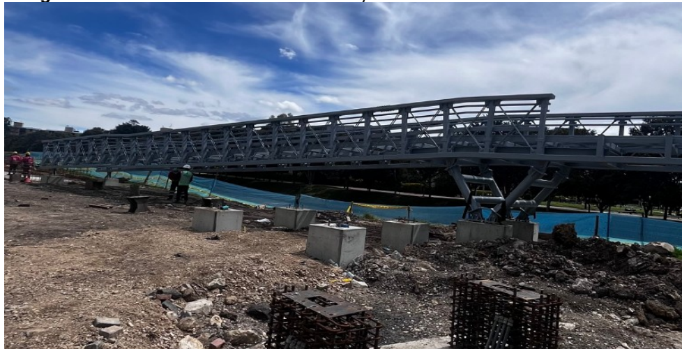
Fotografía N°4: Estructura Metálica izada, en costado occidental el 21/07/2026.
