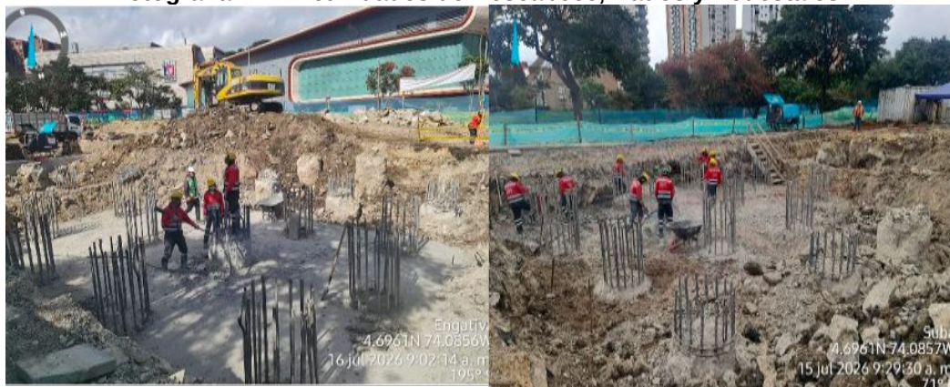
Fotografía N°1: Actividades de Descabece, Dados y Pedestales.
