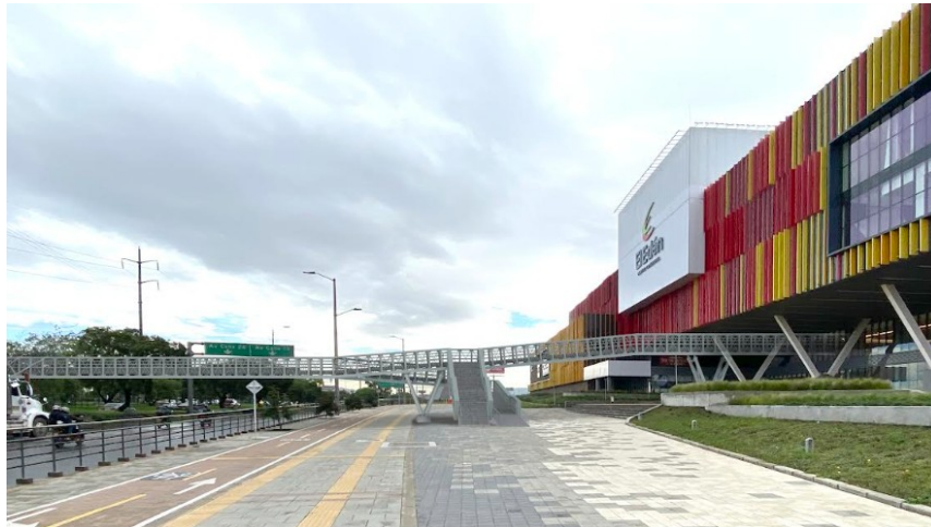
Imagen 1 – Puente Peatonal en sector del centro comercial. Fuente Construcciones Planificadas
