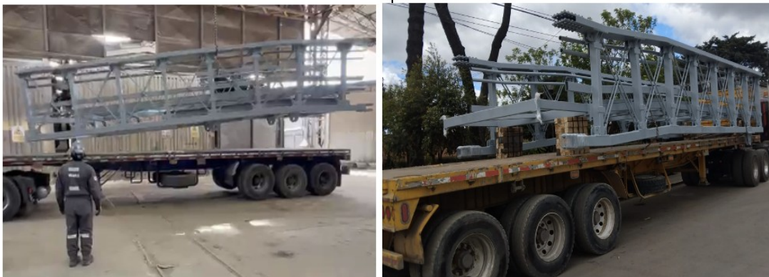
Fotografía N°3: Cargue y traslado de Estructura metálica desde la planta de producción hacia los frentes de obra.
