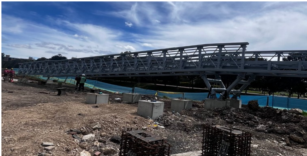
Fotografía N°4: Estructura Metálica izada, en costado occidental el 21/07/2026.
