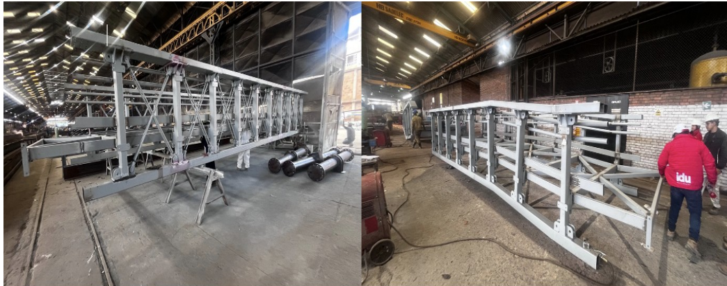
Fotografía N°2: Avance de Estructura Metálica, en visita a planta realizada el 14/07/2026.
