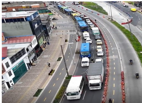
Imagen Ciclorruta construida entre Calle 13 hasta calle 11
