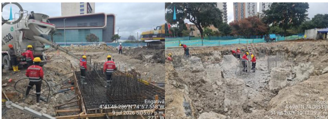
Fotografía N°1: Actividades de Descabece, construcción de dados y Pedestales.
