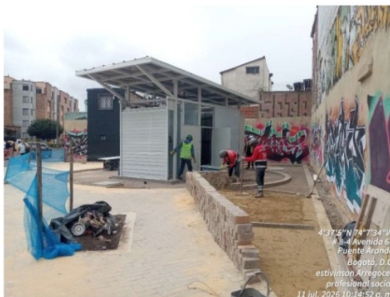
Construcción espacio público y taquilla calle 8 sur: Fuente: Elaboración propia
