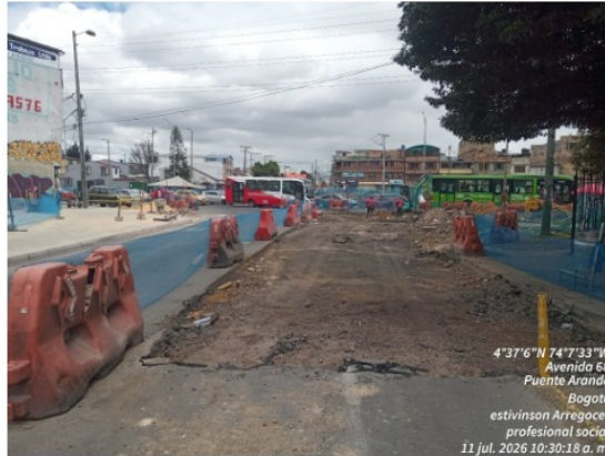
Construcción carril mixto calle 8 sur costado norte. Fuente: Elaboración propia
