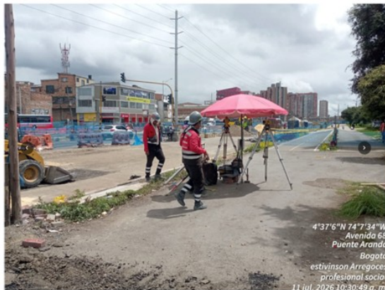
Trabajos de adecuación carril mixto al norte de la calle 8 sur. Fuente: Elaboración propia
