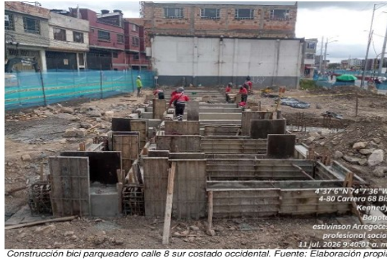
Construcción bici parqueadero calle 8 sur costado occidental. Fuente: Elaboración propia
