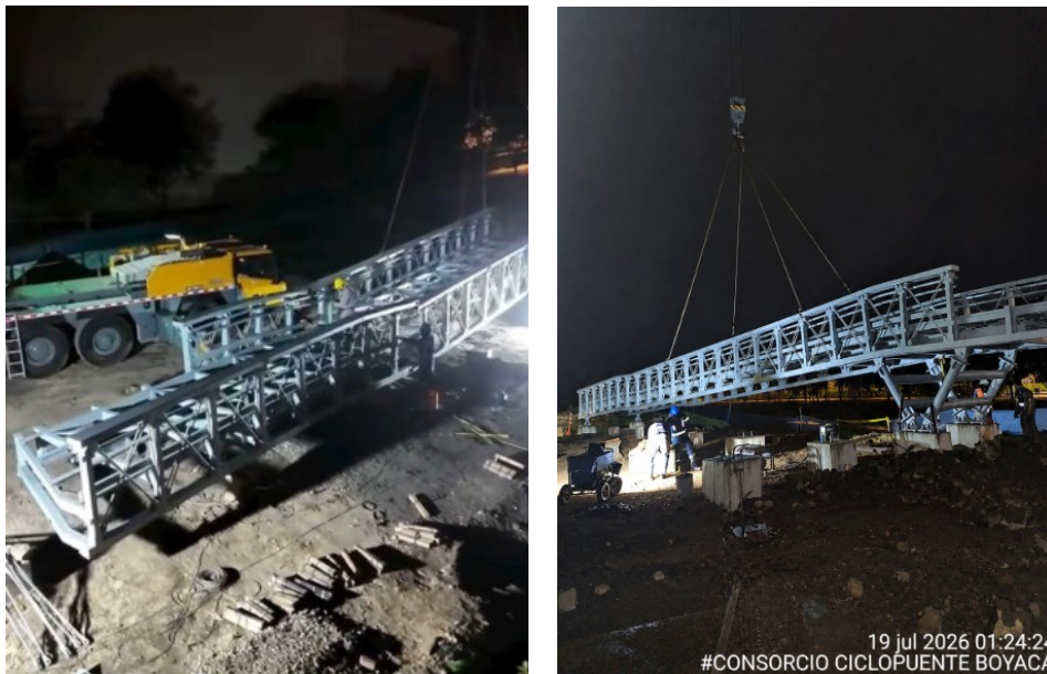
Fotografía N°: Prensamblaje e izaje de tramos metálicos de rampas del puente.
