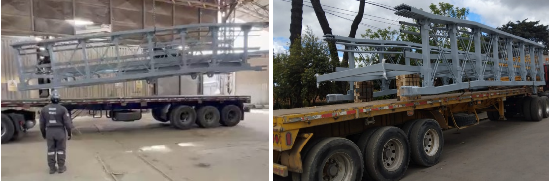
Fotografía N°3: Cargue y traslado de Estructura metálica desde la planta de producción hacia los frentes de obra.
