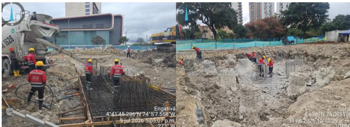
Fotografía N°1: Actividades de Descabece, Dados y Pedestales.
