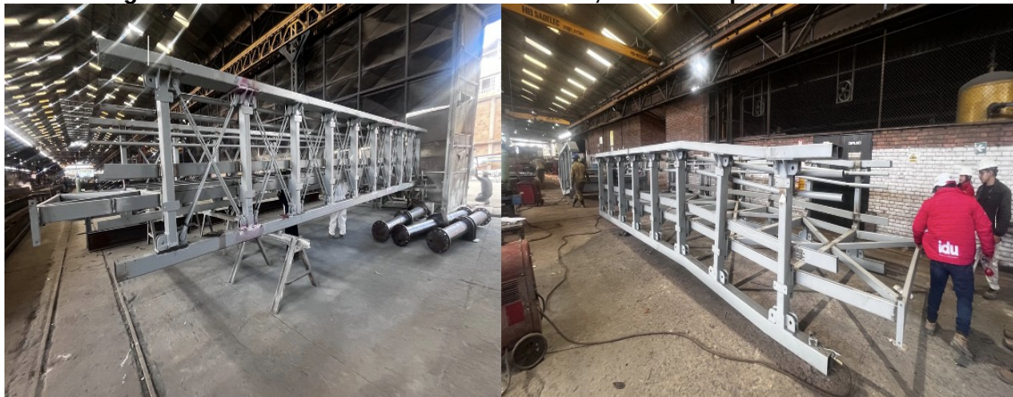
Fotografía N°2: Avance de Estructura Metálica, en visita a planta el 14/07/2026.
