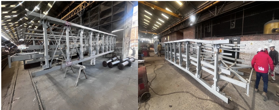
Fotografía N°2: Avance de Estructura Metálica, en visita a planta de producción realizada el día 14/07/2026.
