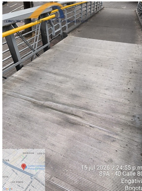
Fotografía No. 1 estado actual del puente
