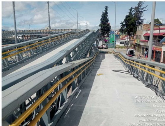
Rampa costado occidental con escaleras. Fuente: Elaboración propia
