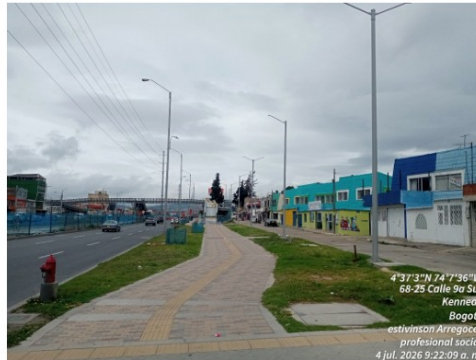
Terminadas las obras de soterrización de redes secas y retiro de postes y redes eléctricas que obstruían la visual (Enel). Fuente: Elaboración propia
