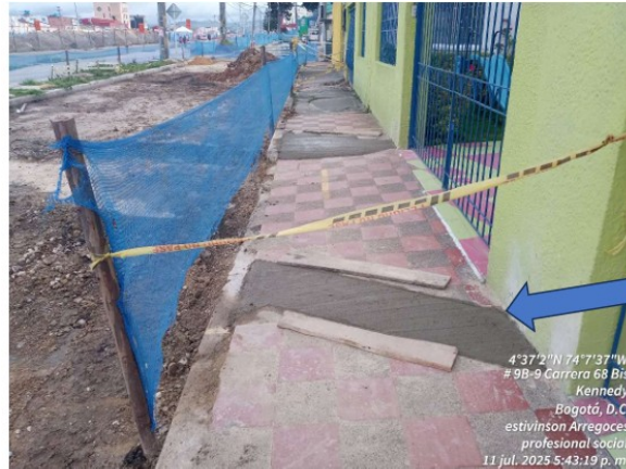
Subterrización de ductería para control de Interferencias redes secas. Fuente: Elaboración propia
