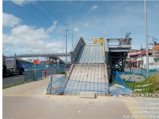
Construcción de rampa costado occidental. Fuente: Elaboración propia
