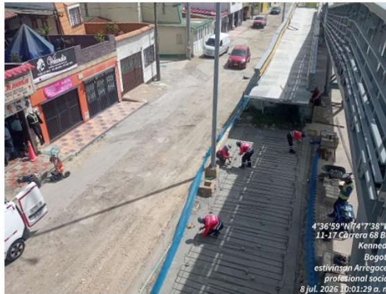
Construcción de rampa costado occidental. Fuente: Elaboración propia
