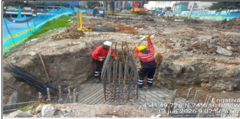
Fotografía N°1: acero de pedestal correspondiente al eje No 5 del costado occidental
