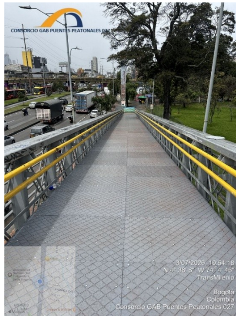
Fotografía 1- Estado actual rampa occidental
