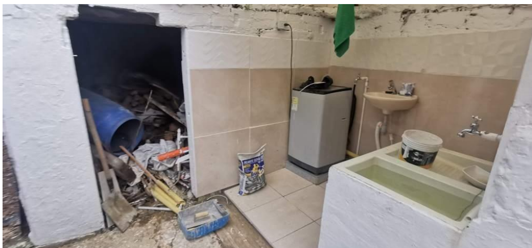
Construcción 3 zona ropas
