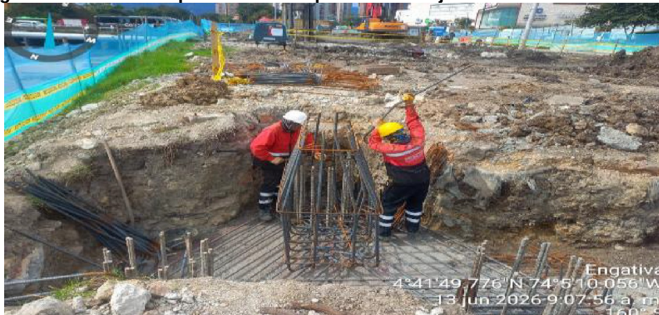
Fotografía N°1: acero de pedestal correspondiente al eje No 5 del costado occidental.
