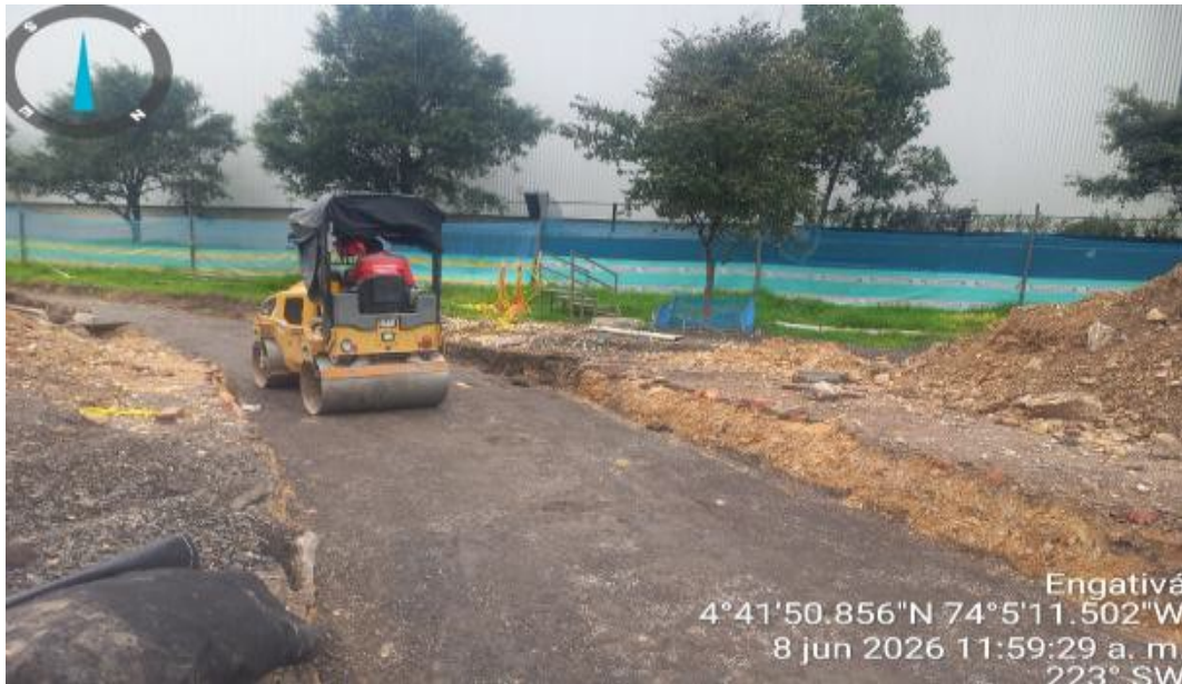
Fotografía N°3: compactación de material de relleno en la vía pacificada entre canal salitre y Makro en el costado occidental.
