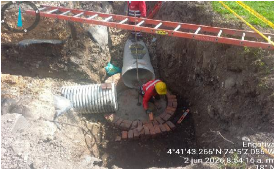
Fotografía N°2: red pluvial del costado oriental.
