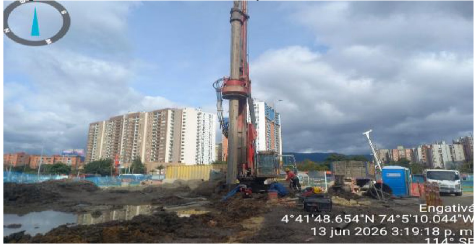
Fotografía N°2: excavación mecánica del pilote No 50 del costado occidental.
