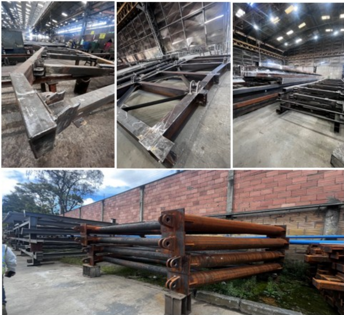
Fotografía N°6: Avance de Estructura Metálica, en visita a planta el 17/06/2026, el cual presenta avance por encima del 50% de su fabricación.
