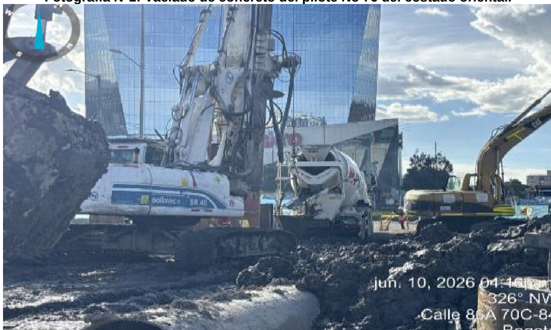
Fotografía N°1: Vaciado de concreto del pilote No 76 del costado oriental.
