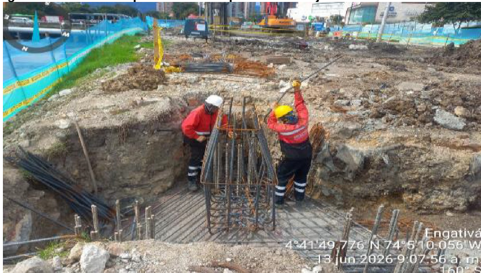
Fotografía N°3: acero de pedestal correspondiente al eje No 5 del costado occidental.
