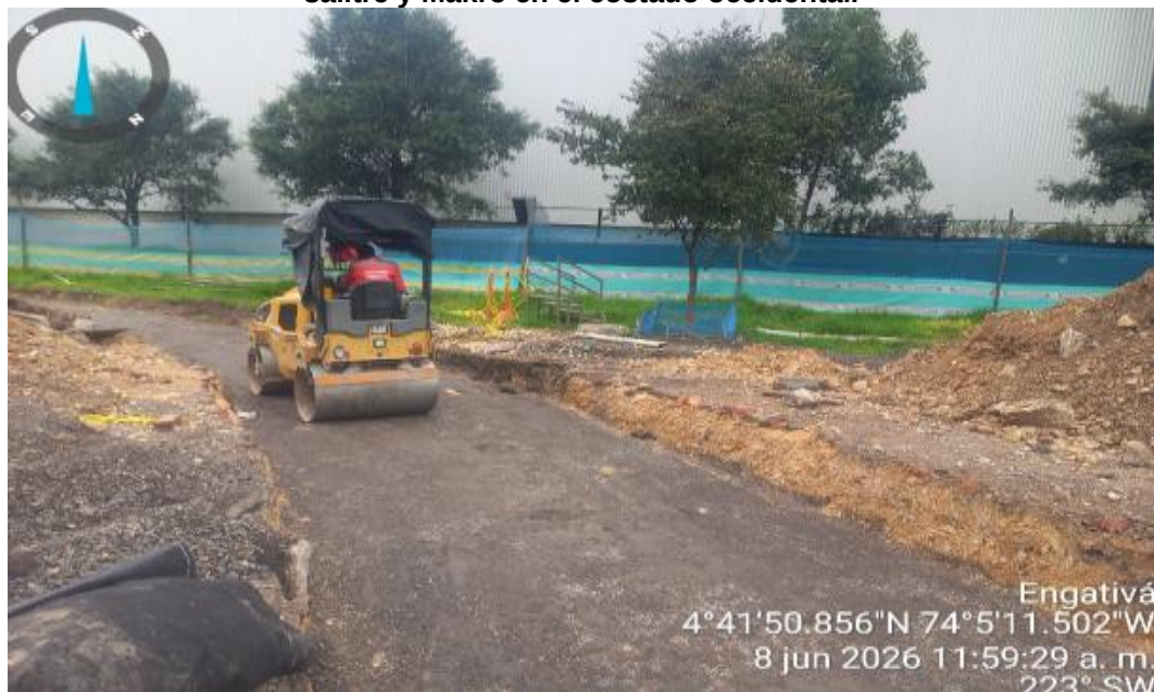
Fotografía N°5: compactación de material de relleno en la vía pacificada entre canal salitre y Makro en el costado occidental.
