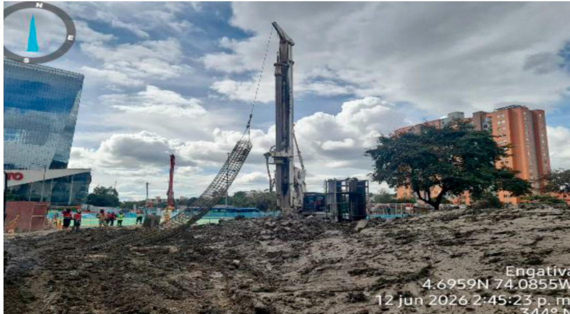
Fotografía N°1: izaje e Instalación de canastilla de acero de refuerzo para pilotes en el costado oriental.
