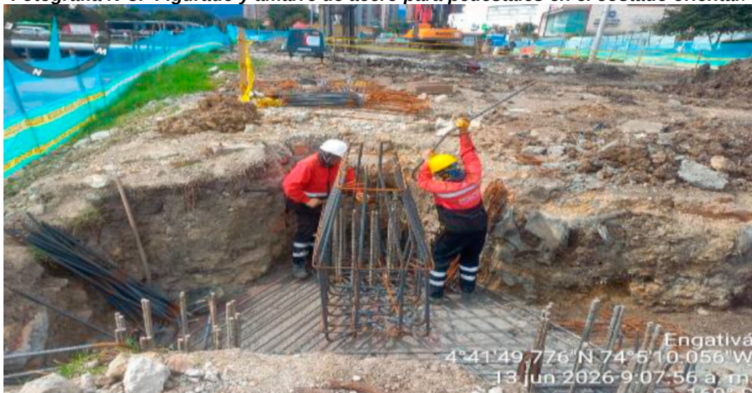
Fotografía N°3: Figurado y amarre de acero para pedestales en el costado oriental.
