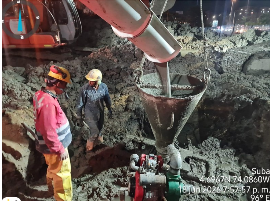
Fotografía N°2: Vaciado de concreto para pilotes en el costado occidental.
