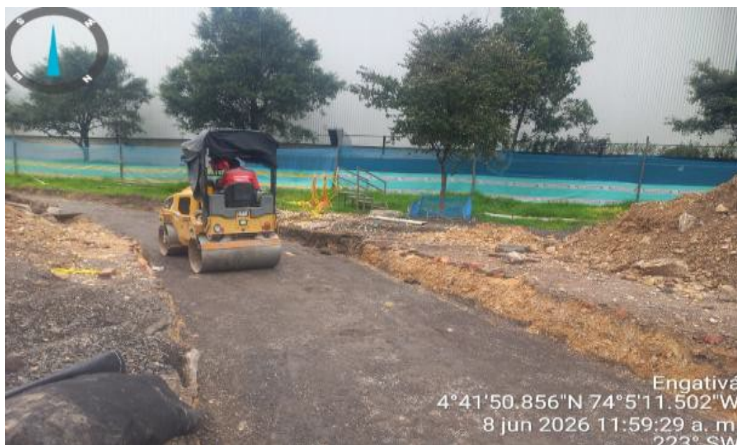
Fotografía N°6: Conformación de terreno de la vía pacificada entre Makro y canal salitre (Costado occidental)
