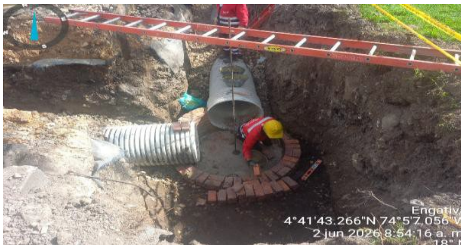
Fotografía N°5: Construcción de pozo para desvío de red sanitaria, costado oriental
