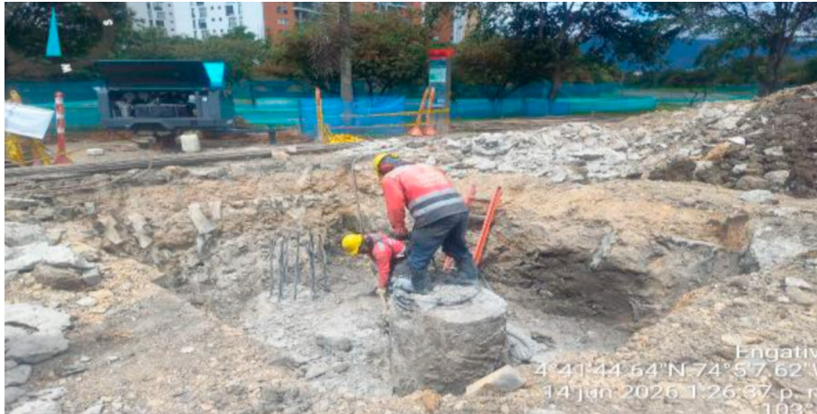
Fotografía N°4: Descabece de pilotes para construcción de dados de cimentación
