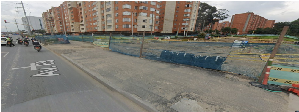
Grupo 4 Calle 22 con Av 68 costado Oriental.
