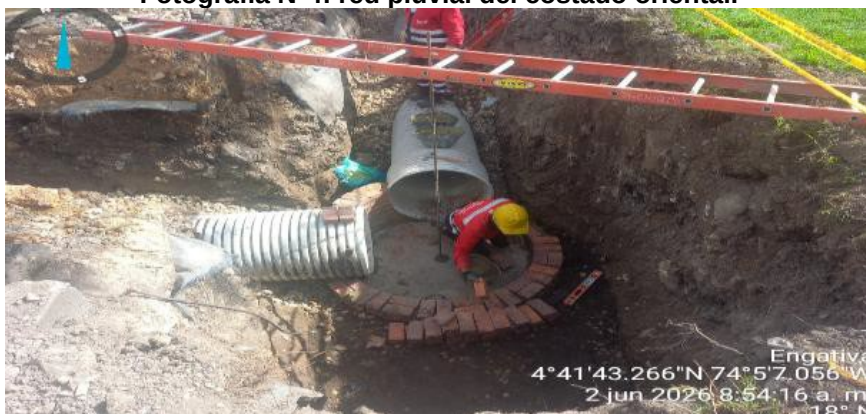
FUENTE: Interventoría CAL Y MAYOR COLOMBIA S.A.S
