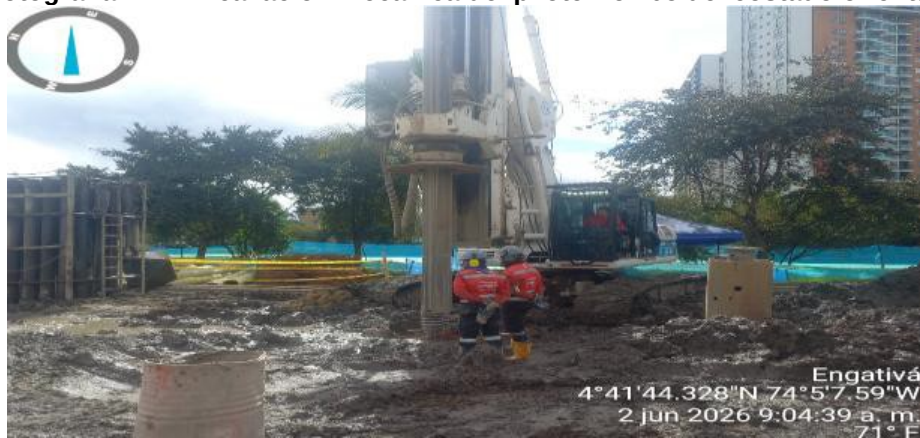
Fotografía N°1: Excavación mecánica del pilote No 105 del costado oriental.
