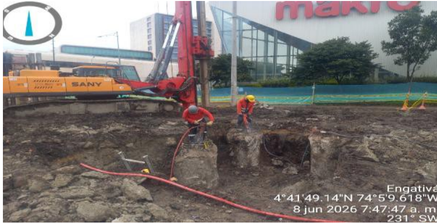
FUENTE: Interventoría CAL Y MAYOR COLOMBIA S.A.S
