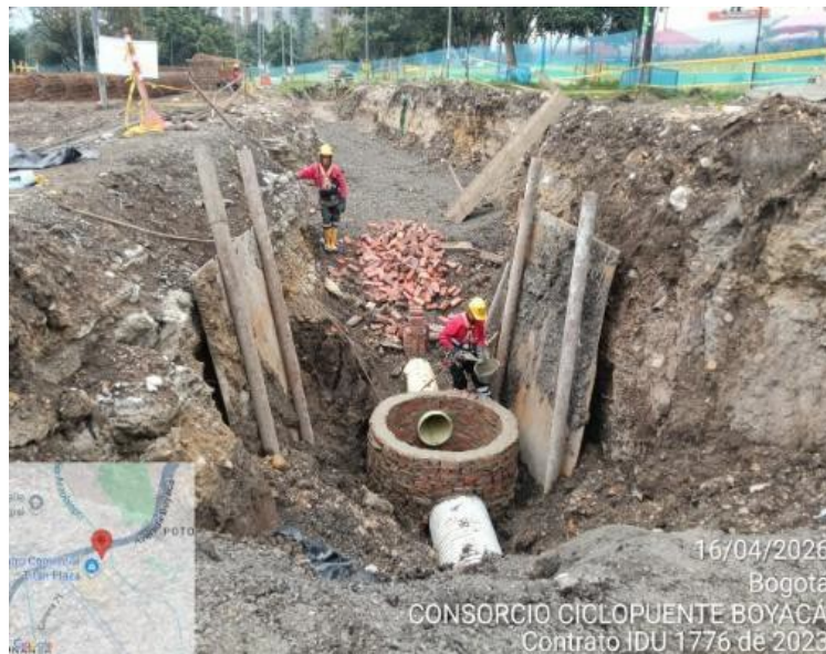
Imagen No. 04 – Construcción pozos de inspección red sanitaria Fuente: Contrato IDU 1776-2023
