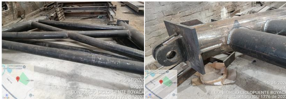
Imagen No. 06 – Fabricación estructura metálica Fuente: Contrato IDU 1776-2023
