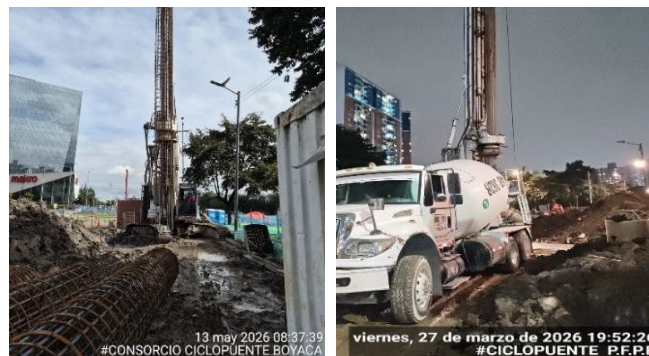
Imagen No. 02 – Construcción de pilotes costado occidental y oriental (instalación acero de refuerzo y posterior vaciado de concreto) Fuente: Contrato IDU 1776-2023
