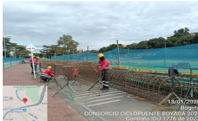
Imagen No. 01 – Armado de canastas de acero de refuerzo para pilotes Fuente: Contrato IDU 1776-2023
