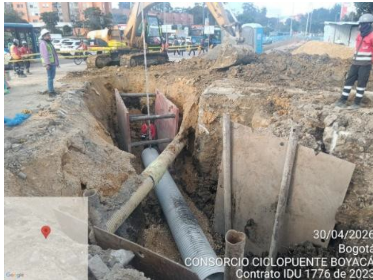
Imagen No. 05 – Construcción red alcantarillado sanitario Fuente: Contrato IDU 1776-2023
