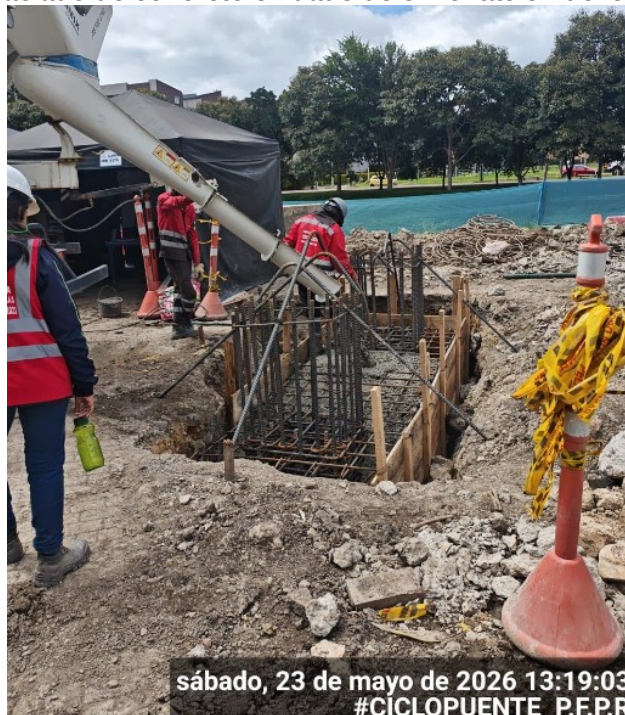
Fotografía N°3: Vaciado de concreto en dado de cimentación del costado occidental.
