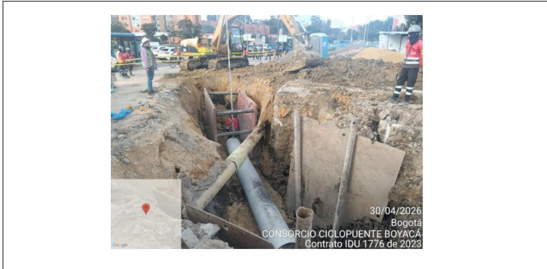
Imagen No. 05 – Construcción red alcantarillado sanitario
