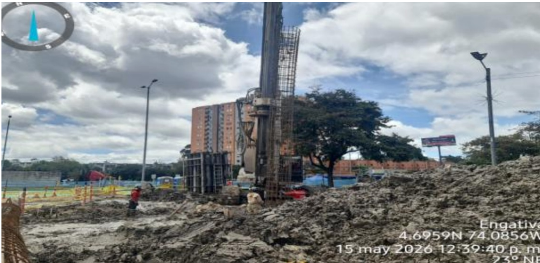
Fotografía N°1: Instalación de canastilla de acero de refuerzo para pilotes en el costado oriental.
