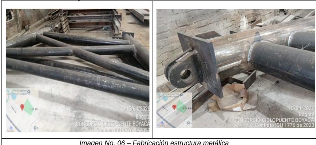
Imagen No. 06 – Fabricación estructura metálica
