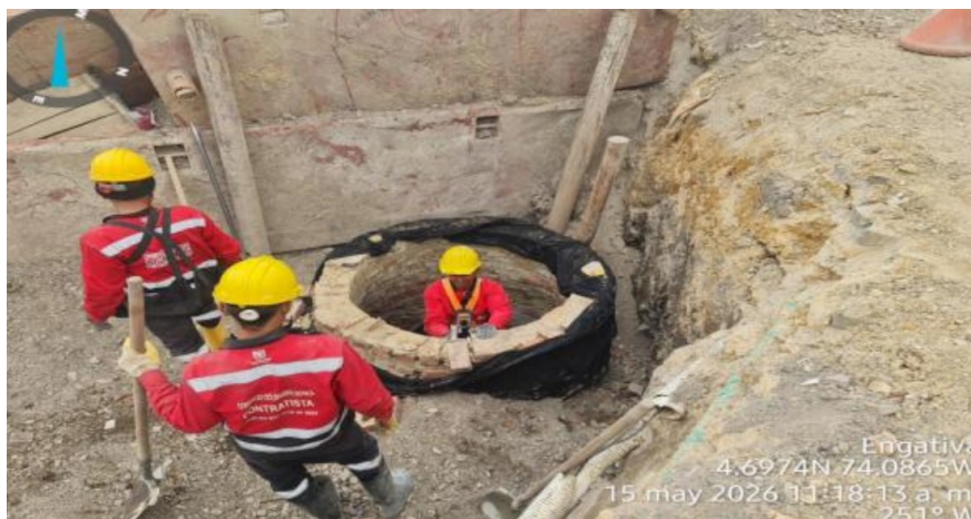
Fotografía N°5: Construcción de pozo de inspección para desvío de red sanitaria, costado oriental
