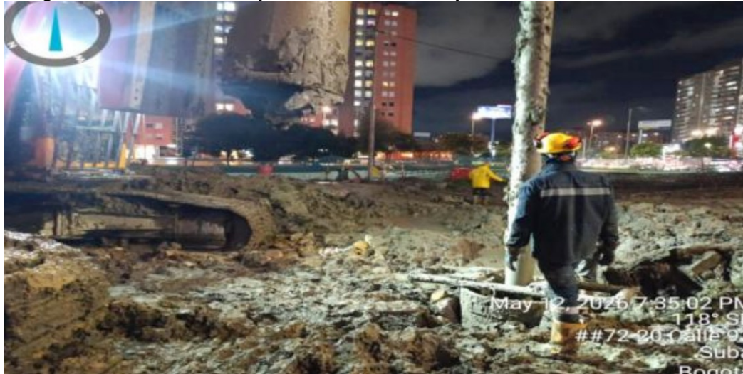
Fotografía N°2: Perforación para construcción de pilotes en el costado occidental.
