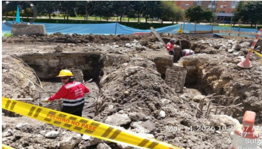
Fotografía N°4: Descabece de pilotes para construcción de dados de cimentación
