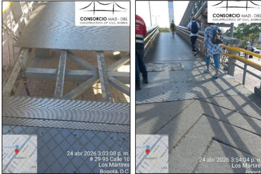
Fotografía No. 7 y No.8: Antes y después de la intervención
