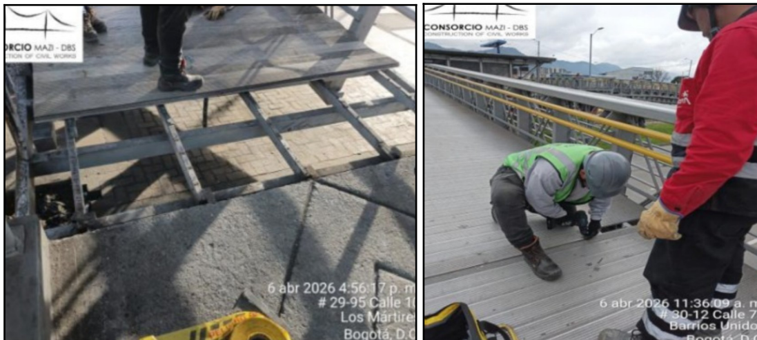
Fotografía No. 1 y No.2: Antes y después de la intervención
