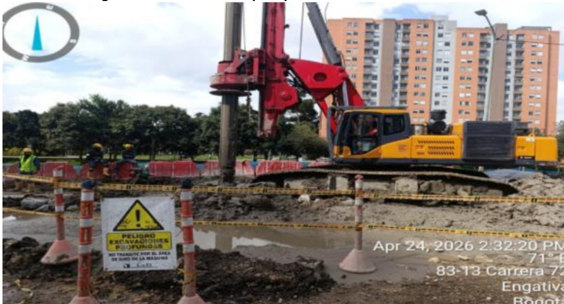
Fotografía N°3: Perforación para pilotes del costado occidental.
