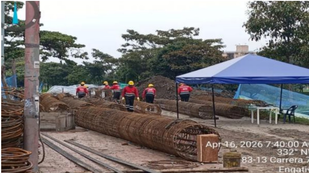
Fotografía N°3: Amarre y figurado de acero para canastilas de pilotes del costado occidental.
