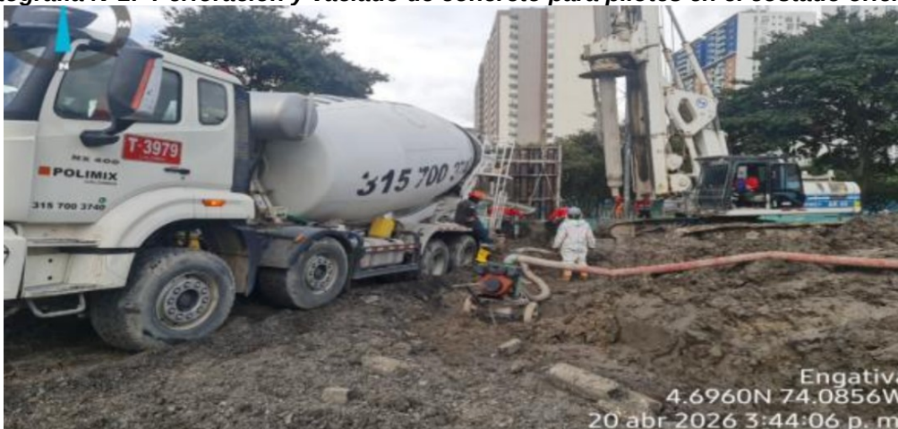
Fuente: Interventoría CAL Y MAYOR COLOMBIA S.A.S
