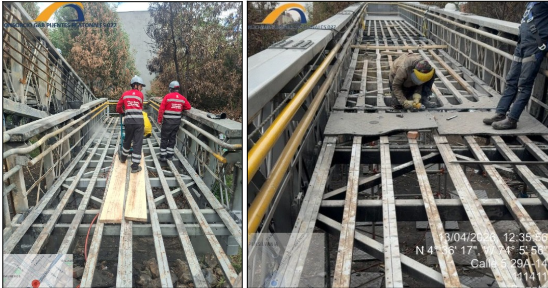
Fotografía No.1 y No.2 – Intervención retiro de piso afectado
