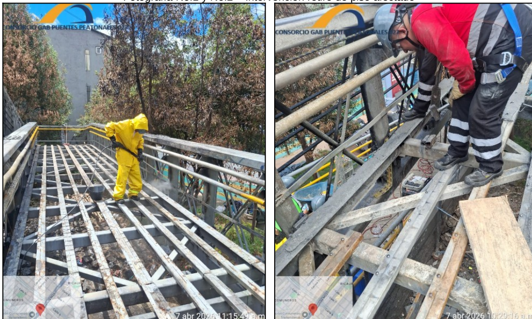
Fotografía No.3 y No.4 – Lavado de estructura y retiro de correas
