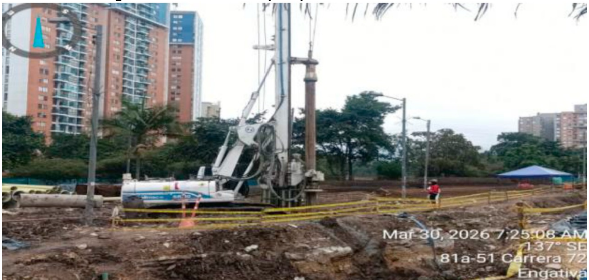
Fotografía N°1: Perforación para pilotes en el costado oriental.
