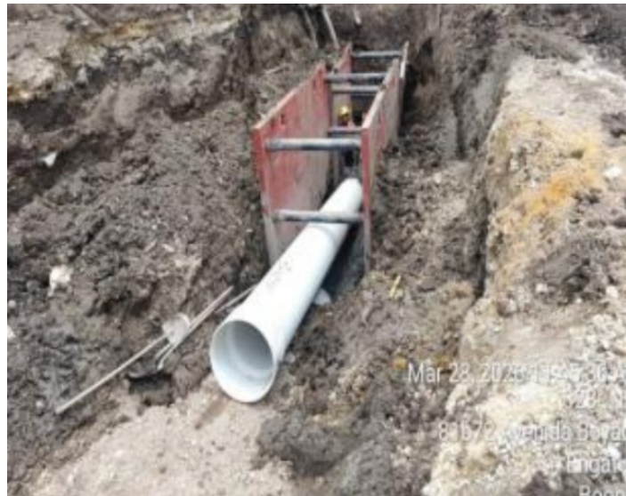
Fuente: Interventoría CAL Y MAYOR COLOMBIA S.A.S
