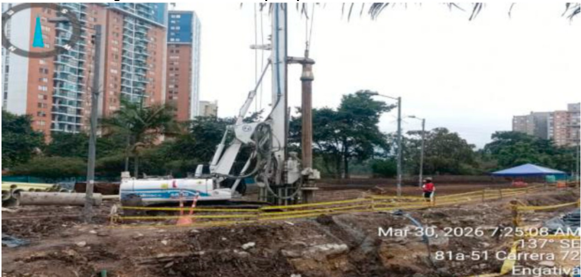
Fotografía N°1: Perforación para pilotes en el costado oriental.
