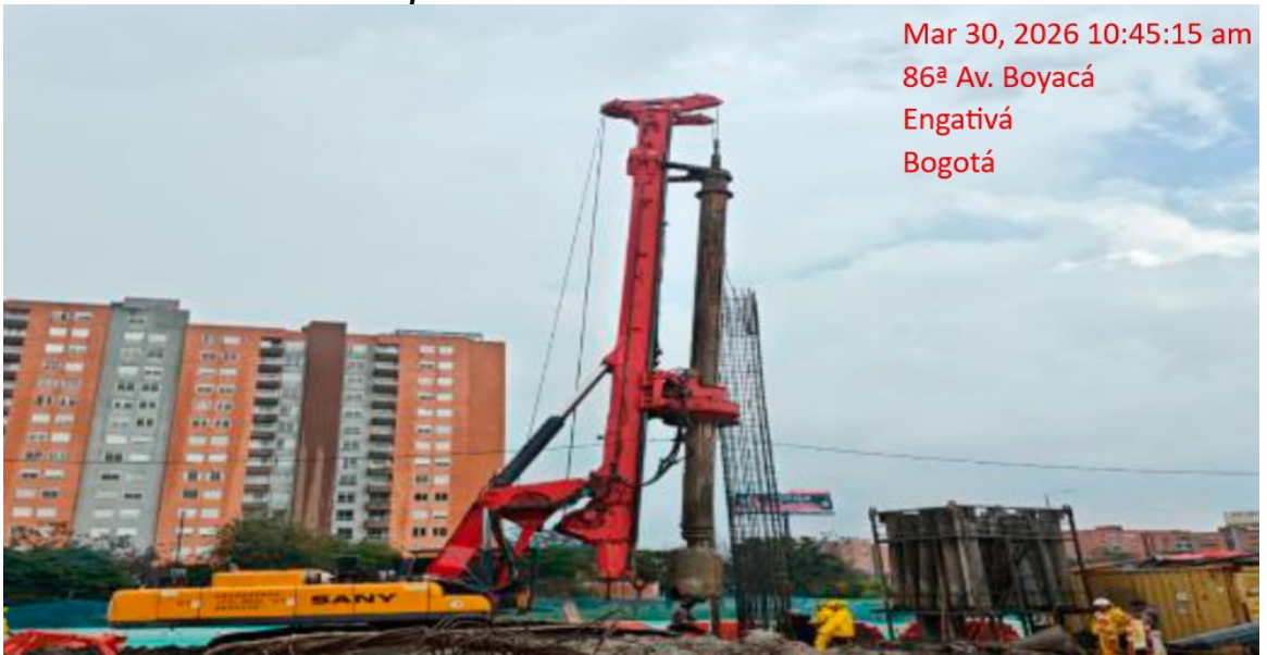
Fotografía N°2: Izaje de canastila de acero para posterior vaciado de concreto para pilotes del costado occidental.
