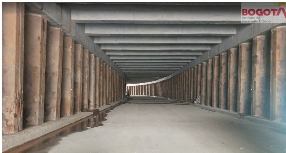
Foto. Interior del Deprimido
