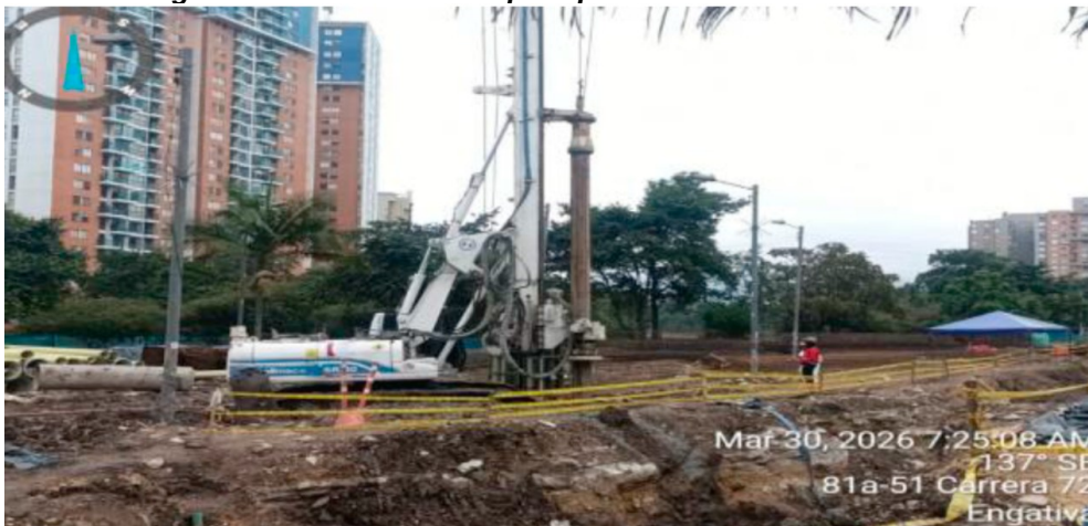
Fotografía N°1: Perforación para pilotes en el costado oriental.
